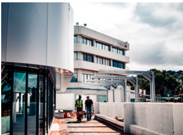
Die Bellville Park-kampusvernuwingsprojek skep instaatstellende leerruimtes: Konstruksie van die nuwe lesingsaal en seminaarkamers vorder goed en behoort in Maart 2019 voltooi te wees.
